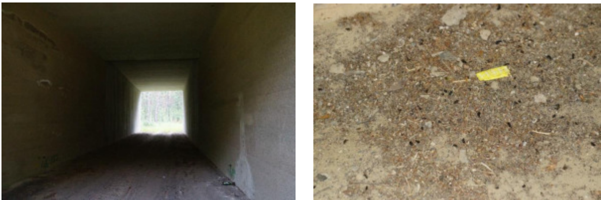
Abbildung 14: Unterführung A 11 mit Kotspuren unbekannter Fledermausart
